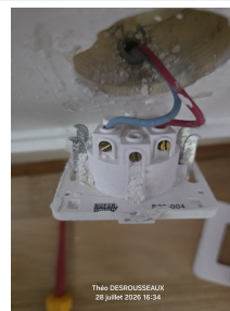
Prise avec borne de terre non reliée (photo A50)
