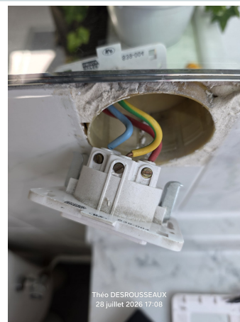
Point avec conducteur de protection présent (A53)
