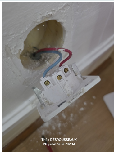
Prise ouverte - borne de terre non alimentée (A48)
